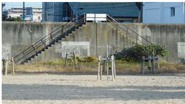
北側の出入口（壁北側は建石線）
