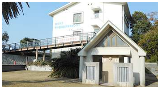
公園内の公衆トイレ
