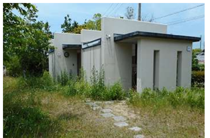
公衆トイレ (山口中学校付近)
